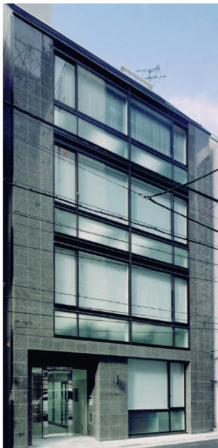
スプリュー新橋ビル
